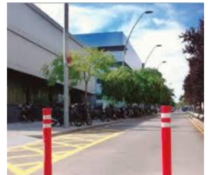
Figura 3. Fita de protecció mecànica
